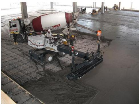
Рис.4 Работа бетоноукладчика зависят не только от площади открытых участков,
