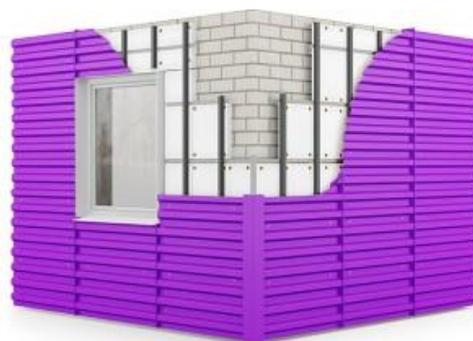
Рис. 5. Облицовка фасада профнастилом
