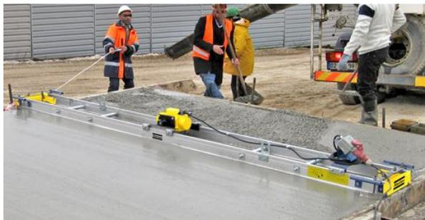
Рис.1 Устройство пола виброрейкой
